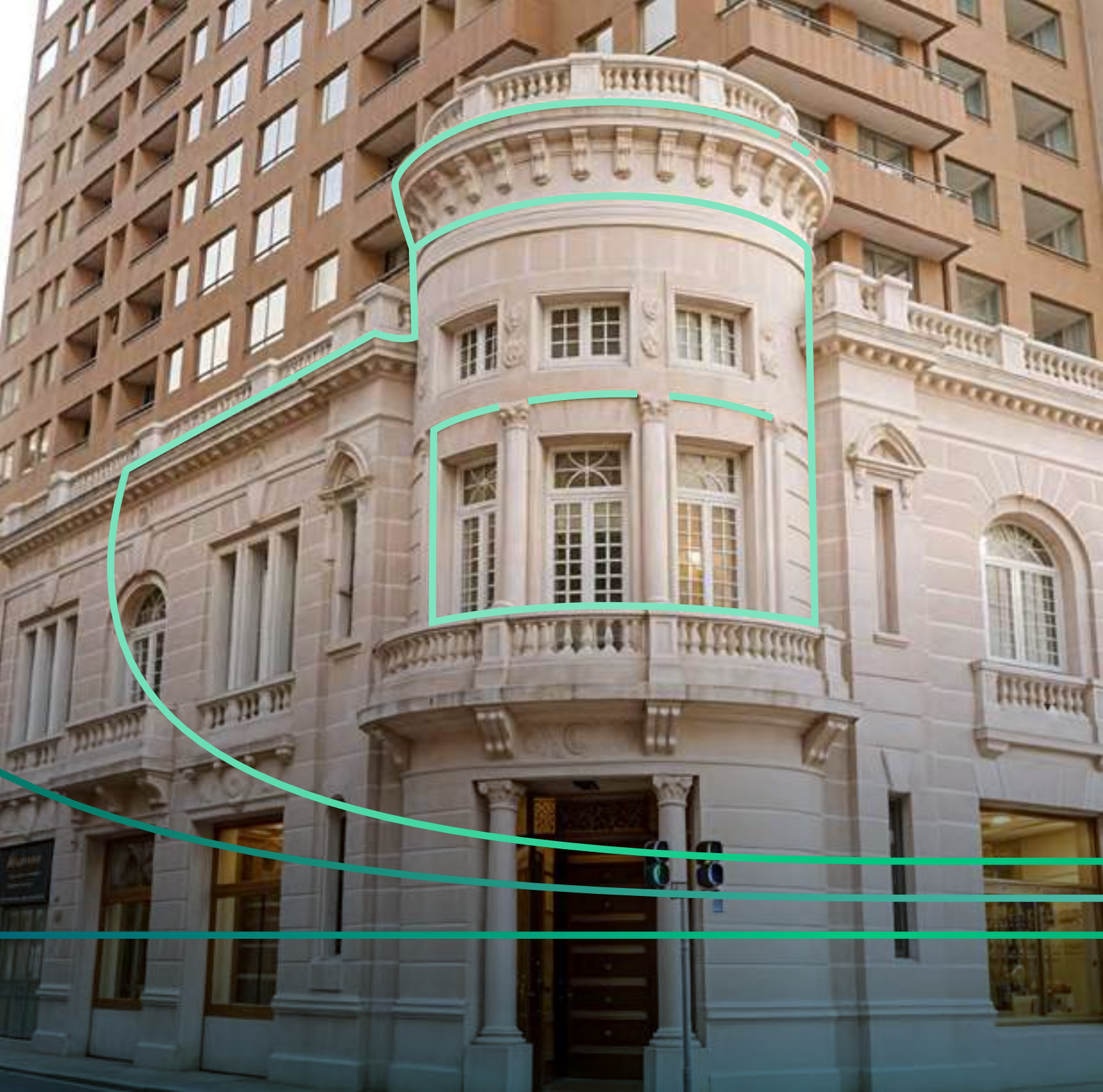
Edificio Amunategui, Santiago. Obra Cbb Ready Mix.
