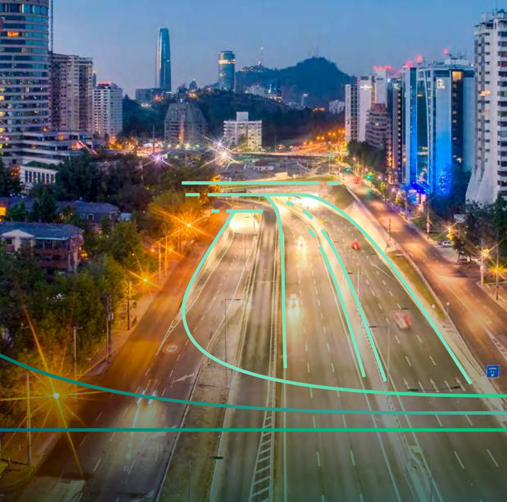
Túnel Kennedy, Santiago. Obra Cbb Ready Mix.
