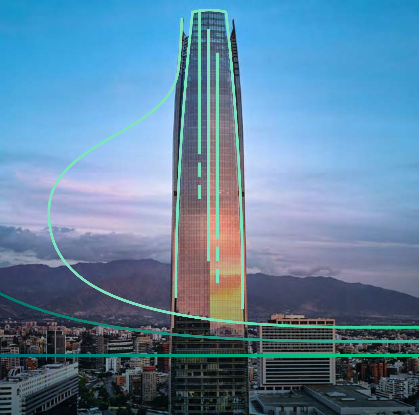
Costanera Center, Santiago. Obra Cbb Ready Mix.
