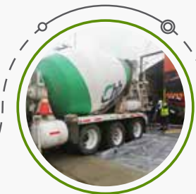
DONACIÓN DE HORMIGÓN A INSTITUCIONES
